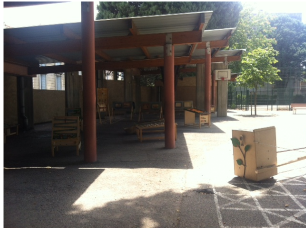
Instal·lació de Toc de Fusta
